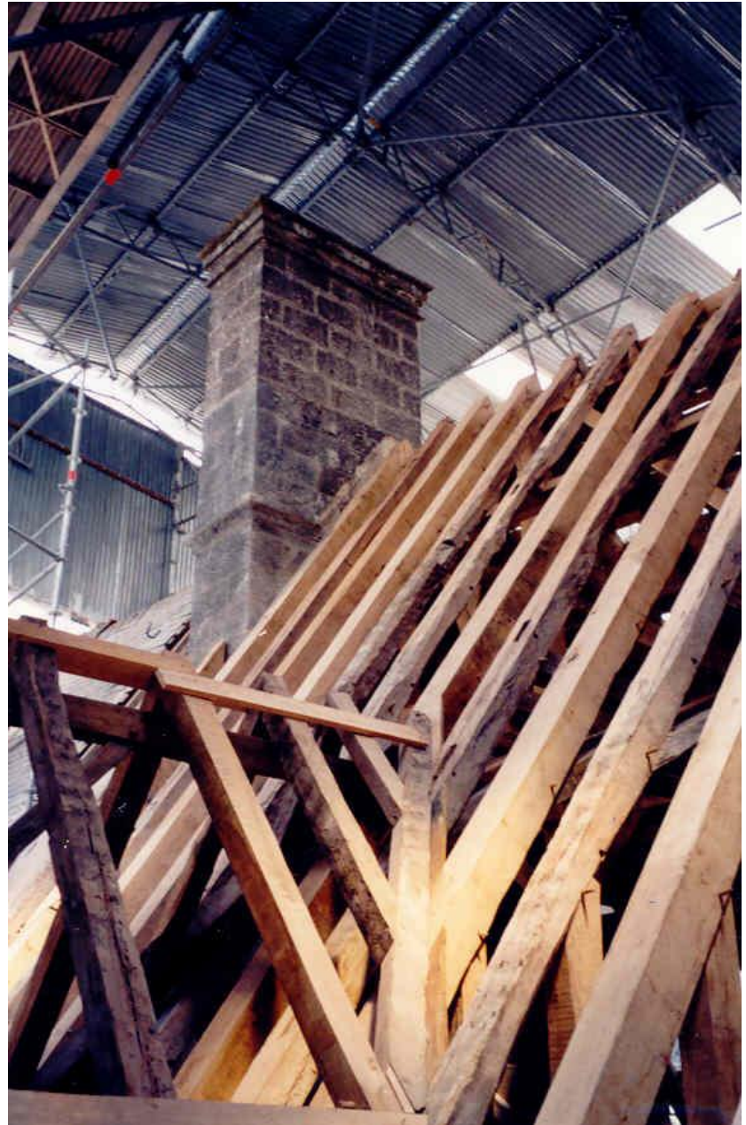
Restauration des charpentes et toitures du château
