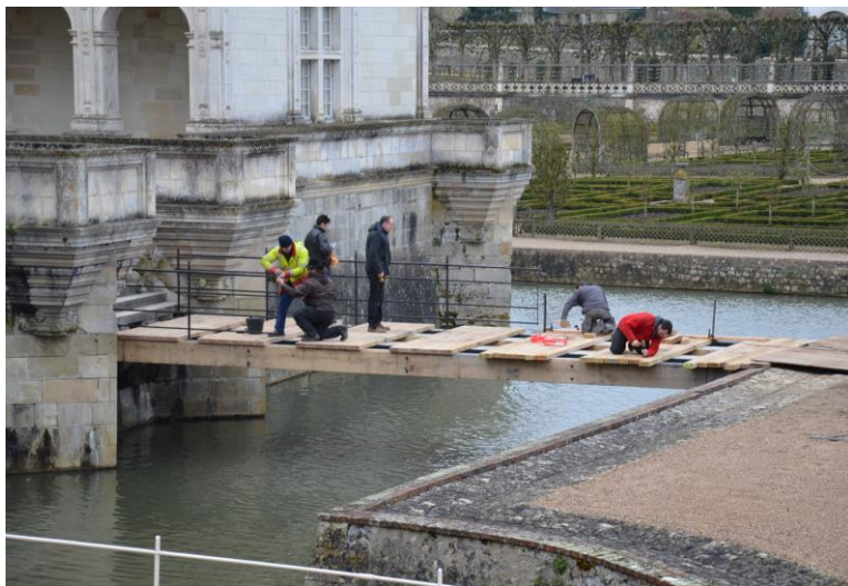
Reconstruction du pont de la cour d'honneur
