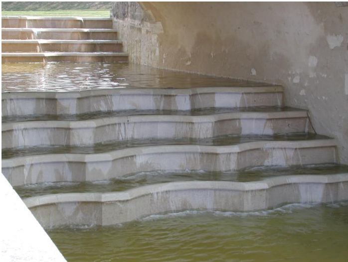
Création de marches d'eau dans les douves
