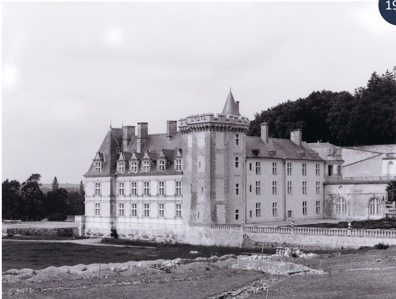
Recherches des fondations du mur de soutènement de l'ancien potager
